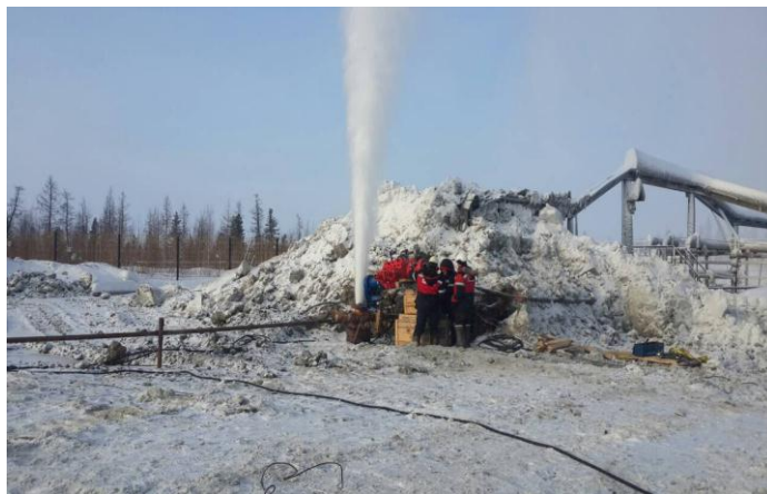
Рис. 2. Фото с места происшествия по капитальному ремонту скважины № 221-Р
